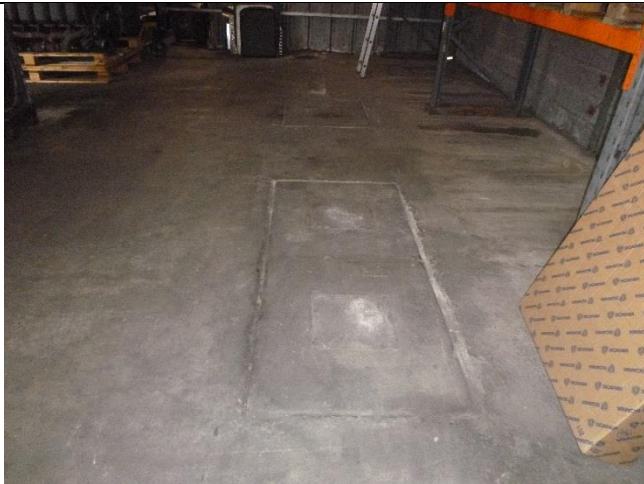
Vue regards cuves enterrées du bâtiment
