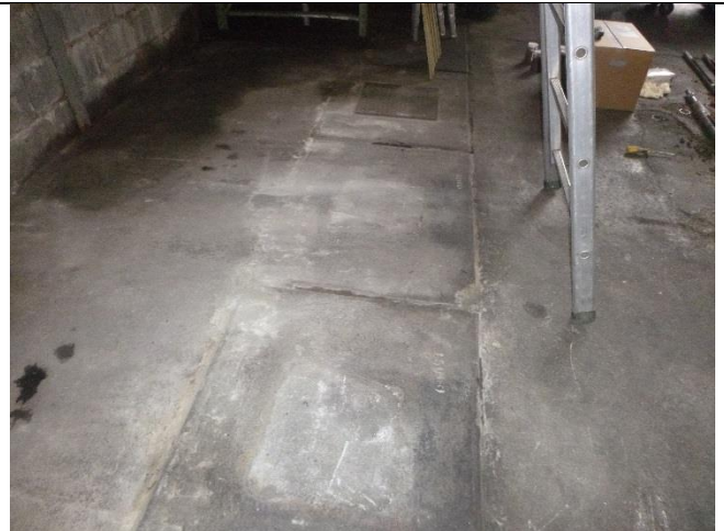
Vue regards cuves enterrées du bâtiment
